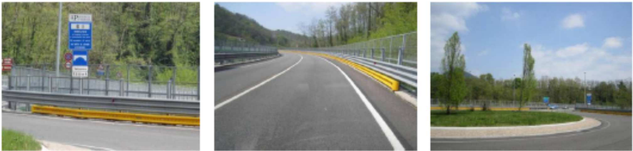
Foto 2.12-2.13-2.14 - Tangenziale Nord-Est di Varese.
