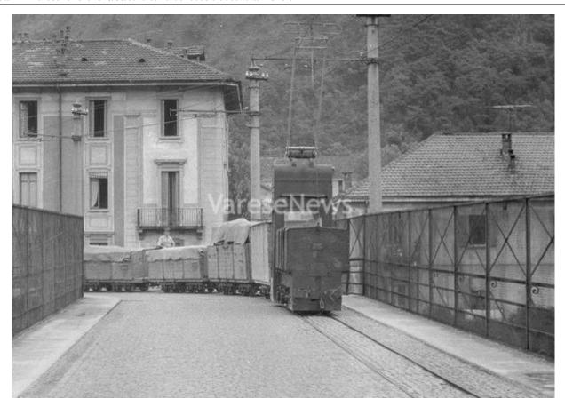
Il Cavalcavia del Boesio è stato costruito negli anni venti per il transito di un trenino ad accumulatori che collegava la Ceramica Lago, alle ceramiche Ponte e Boesio. La costruzione del cavalcavia fu determinata dall'esigenza di superare la linea ferroviaria delle Nord e permettere tramite "la decauville" di collegare le due parti del paese (sul ponte i trenini prendevano la corrente da un cavo sospeso).
