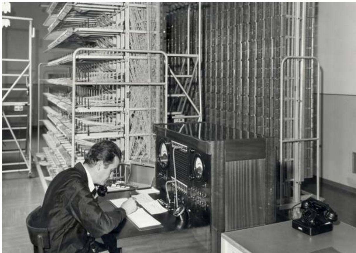
Centrale automatica di Lorenteggio, Milano Sud, 1965 (foto Archivio Storico Gruppo Tim )
