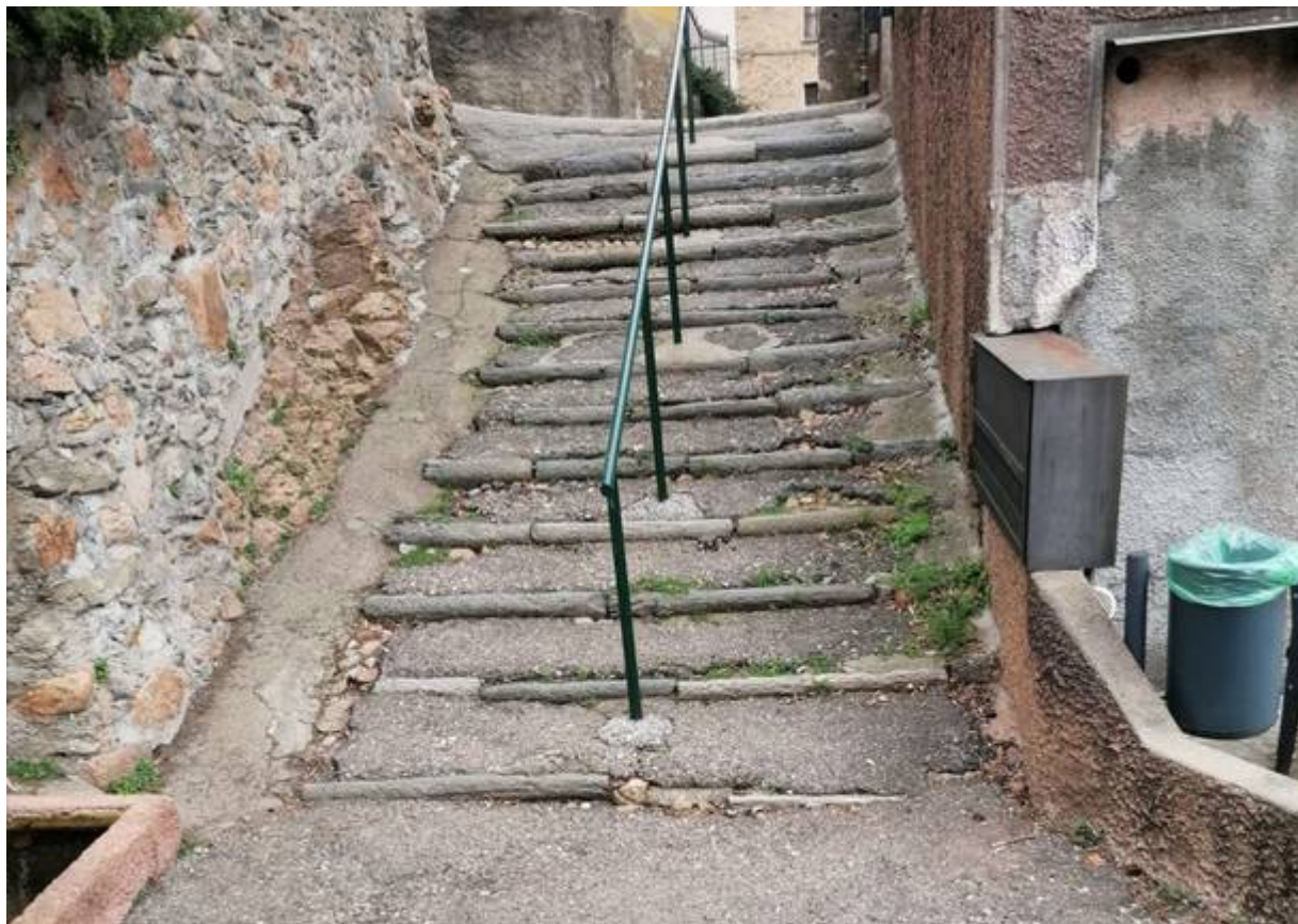
La scaletta di Borgnana prima dell'intervento della Pro loco di Ma.Ge.
