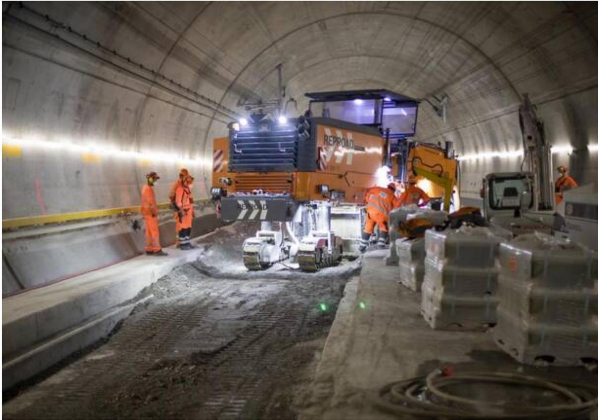
Dall'inizio dei lavori di ripristino nell'ottobre 2023, sono stati completamente **rinnovati sette chilometri di binario, sostituendo le rotaie, oltre a 20mila blocchi delle traverse e lo strato di calcestruzzo** in cui esse sono poste. Nella stazione multifunzionale di Faido sono stati sostituiti anche i due scambi ad alta velocità e gli azionamenti.
